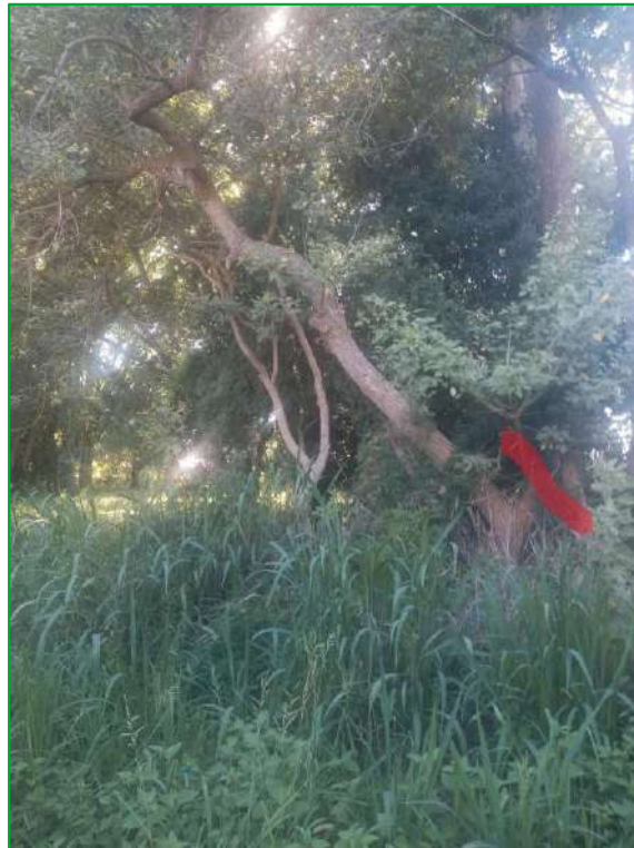
Foto 8 Inclinación y poda mal realizada
